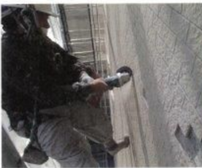
バルコニーのある西側は仮設ゴンドラを使用。タイルの下地調査作業
