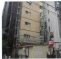
仮設足場は最小限にとどめてメッシュシートで覆ふ
