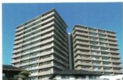
西側（写真左側）と東側から見る。大規模修繕中は、限りある職人の人数や工事機材の数を考慮し、西側→東側の順で実施された
