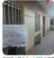
共用廊下側のサッシ周りの劣化を撤廃、見違えるほどきれいになった
