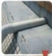
仕上げ時に小穴を開け、エポキシ樹脂注入とアンカーピンニングで補修するS・MC工法
