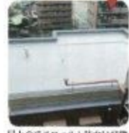
屋上のアスファルト防水は状態が良かったため、トップコート（保護膜）を塗って延命を図る
