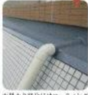
雨掛り部分にはコーティング処理を行いタイルは高圧洗浄しただけで2人にきれいに仕上げる
