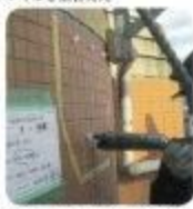
仕上げ時に小穴を開け、エポキシ樹脂注入とアンカーピンニングで補修するS・MC工法
